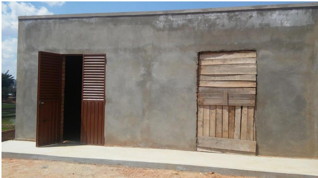
**Protection des travaux finis par un revêtement de béton pour faire face à l'arrivée des pluies.**
